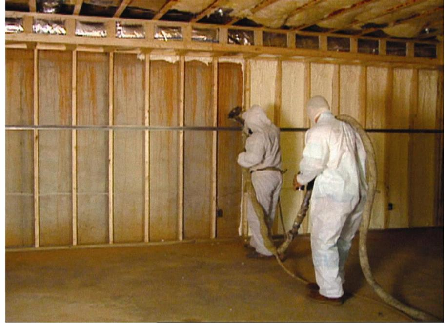
Al igual que el metal, los sustratos de albañilería afectan negativamente el rendimiento de la espuma en aerosol al extraer el calor de la reacción exotérmica de los dos productos químicos. Al fijar el precio de las aplicaciones de albañilería, es necesario aumentar los precios para compensar el consumo de material adicional. En la mayoría de los casos, se recomienda un promedio de 1 "de SPF de célula cerrada en albañilería.
