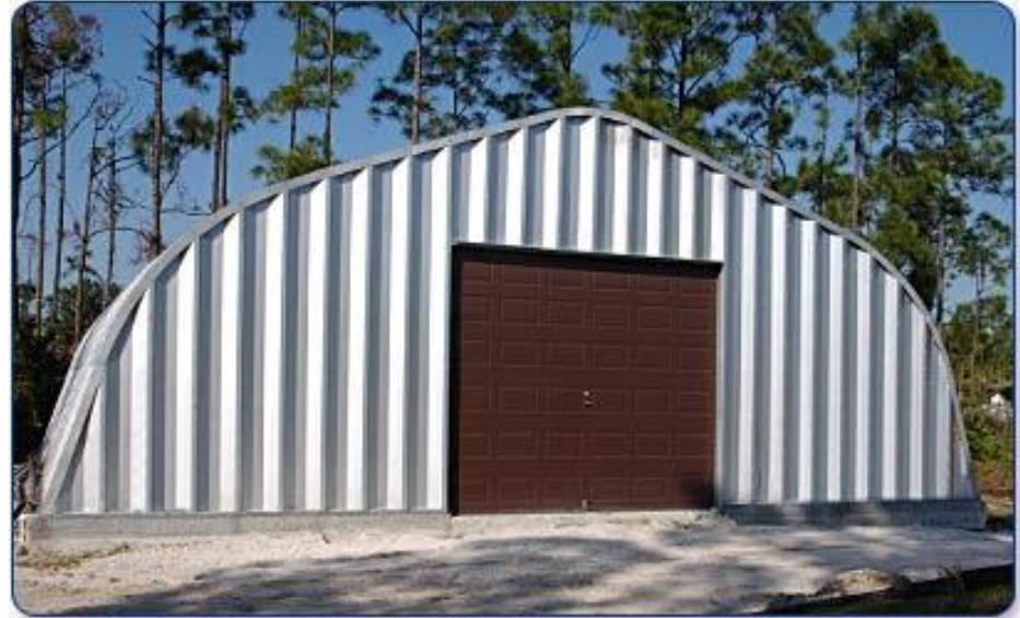
Hay varias cosas a considerar al fijar el precio de las aplicaciones de espuma en aerosol de metal. El metal corrugado, si se estira, podría tener hasta un 50% más de superficie. Además, las aplicaciones de espuma en aerosol de metal en climas fríos podrían producir hasta un 50% menos de cobertura de material. Por lo tanto, debe agregar más dinero al trabajo para compensar el producto adicional requerido.
