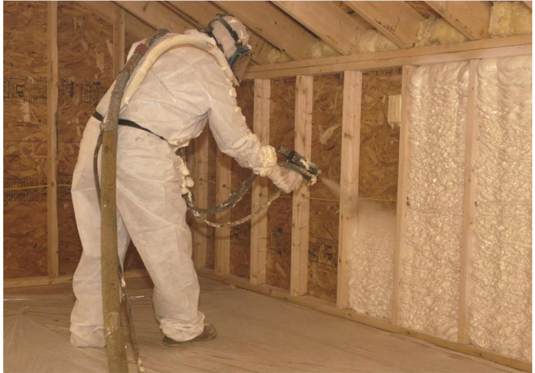
La madera es el sustrato más común para aplicaciones de espuma en aerosol. La mayor preocupación por los problemas con los sustratos de madera es el clima frío. Los precios deben estar inflados para aplicaciones de madera con temperaturas de superficie por debajo de 50 grados F
